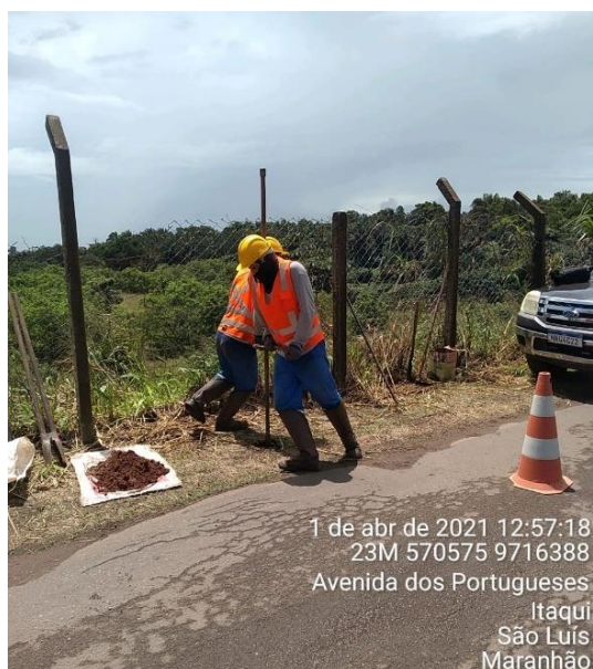
Figura 7: Sondagem a trado no Talude 03
